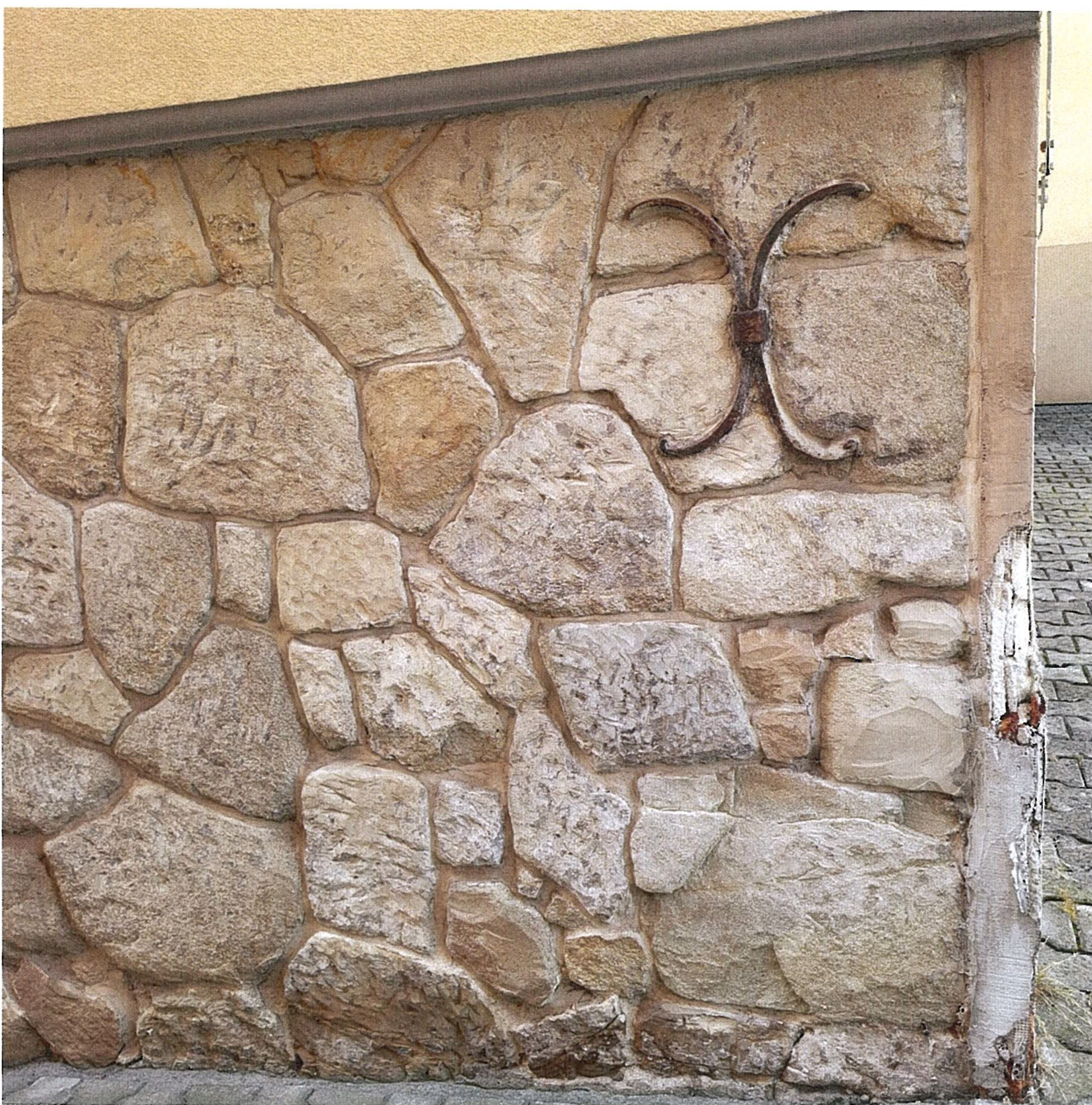
Fot.13. Budynek szkoły - Zespół Jednostek Edukacyjnych Województwa Małopolskiego w Gorlicach - fragment cokołu - podmurówki od strony północnej.
