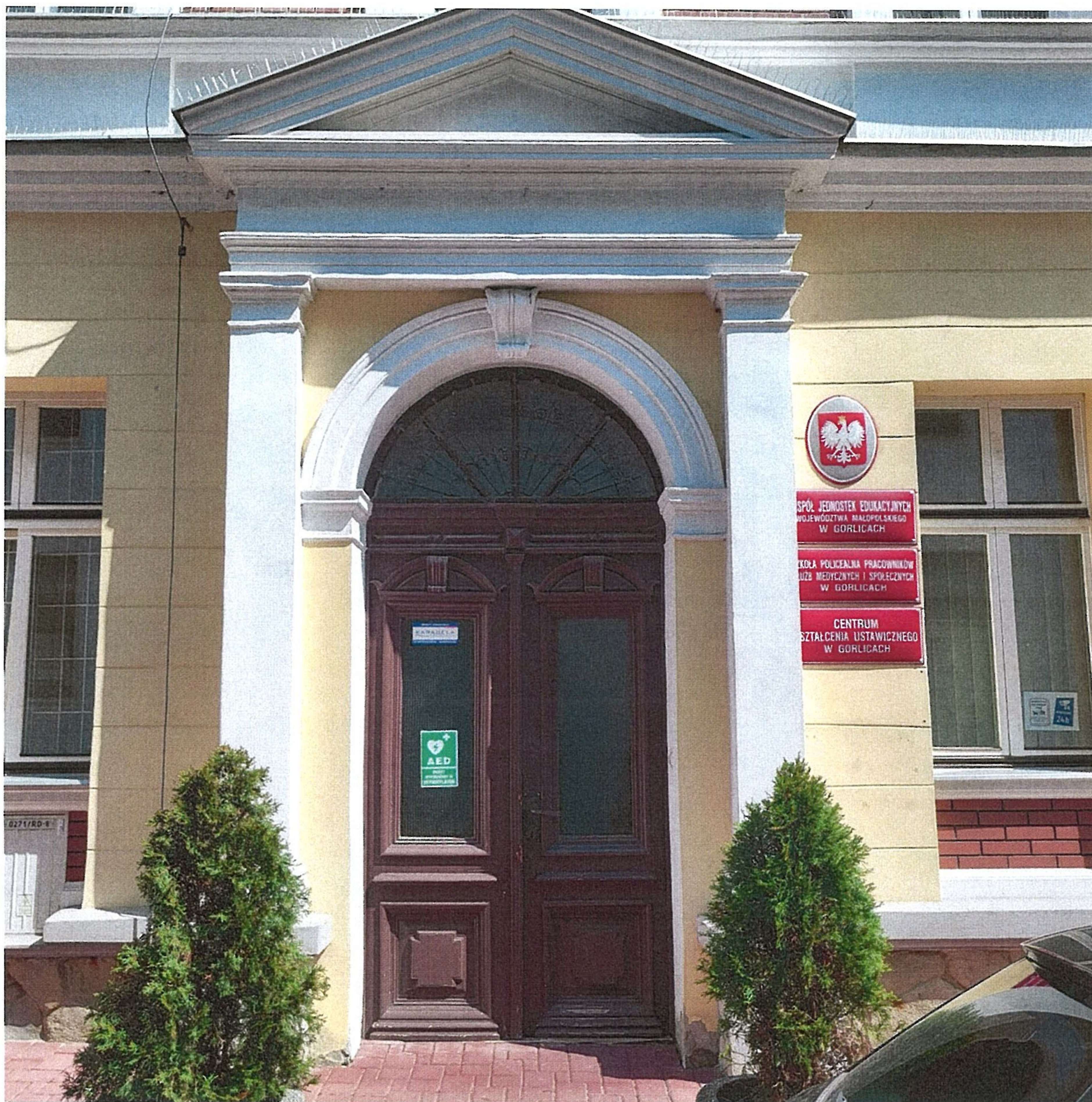
Fot.2. Budynek szkoły - Zespół Jednostek Edukacyjnych Województwa Małopolskiego w Gorlicach - portal, elewacja frontowa.
