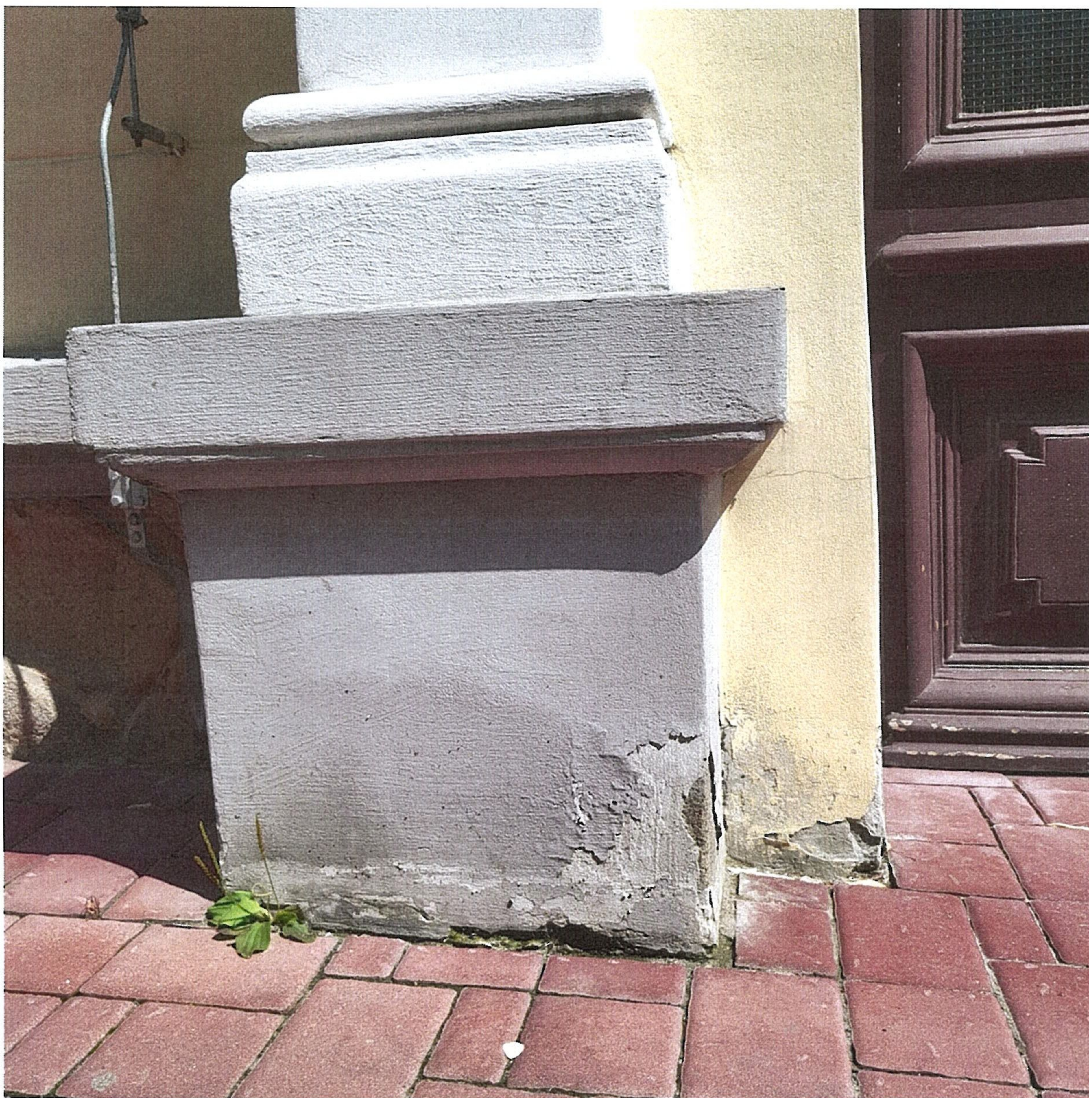
Fot.4. Budynek szkoły - Zespół Jednostek Edukacyjnych Województwa Małopolskiego w Gorlicach - fragment dolnej partii portalu w pasie cokołu - od ulicy Jagiełły.
