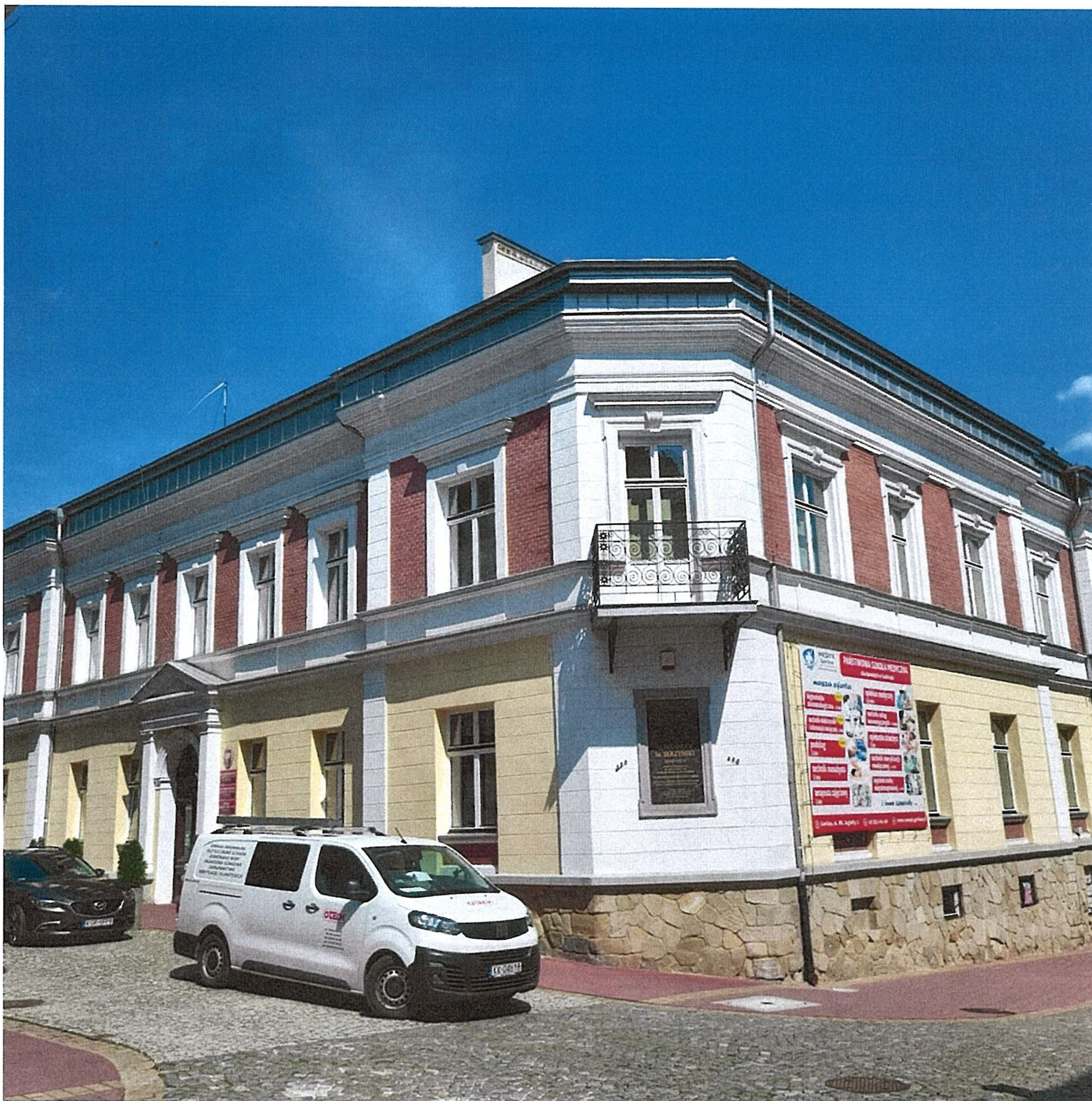
Fot.1. Budynek szkoły - Zespół Jednostek Edukacyjnych Województwa Małopolskiego w Gorlicach - całość obiektu
