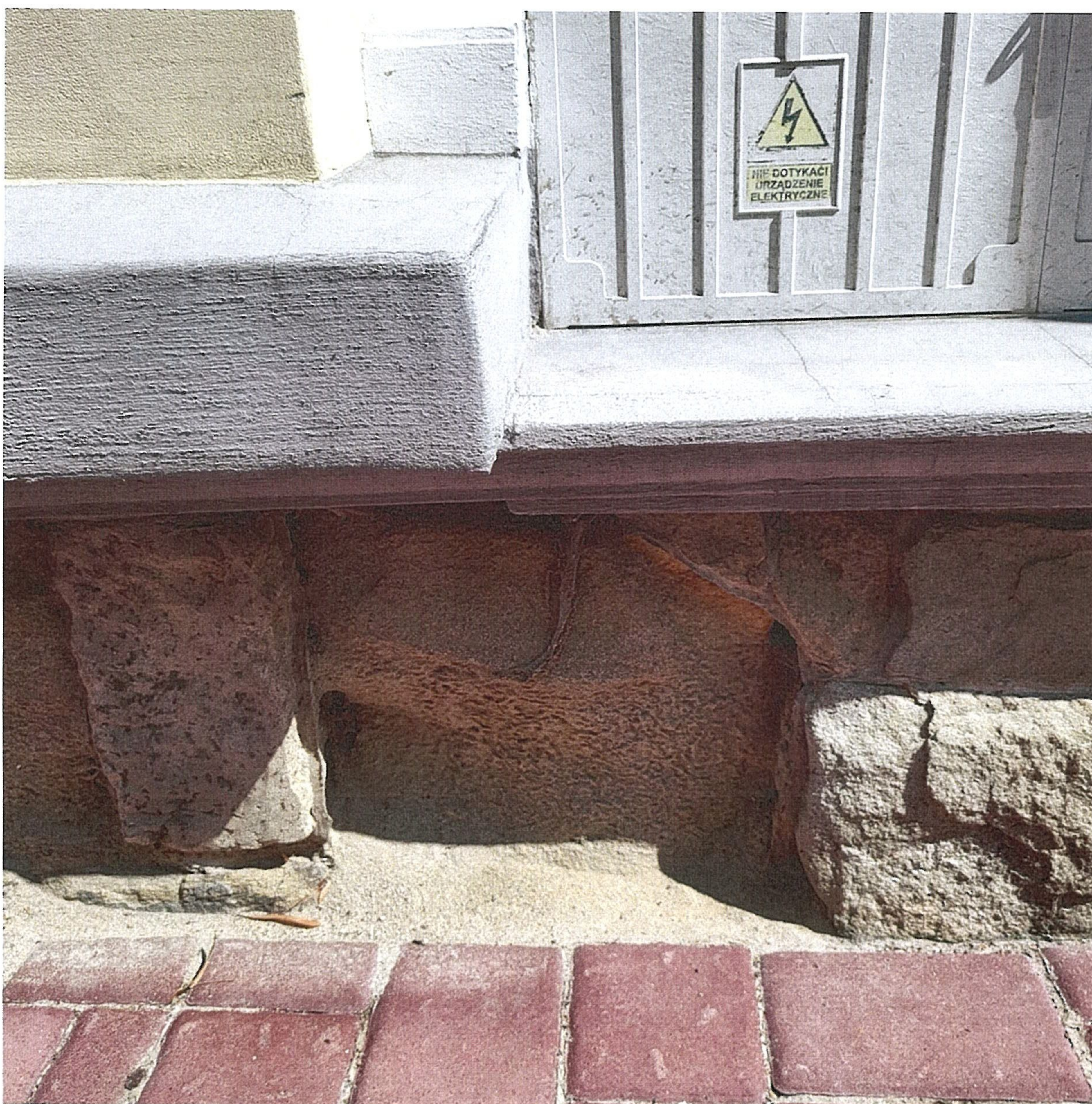
Fot.5. Budynek szkoły - Zespół Jednostek Edukacyjnych Województwa Małopolskiego w Gorlicach - fragment cokołu, podmurówki - od ulicy Jagiełły.
